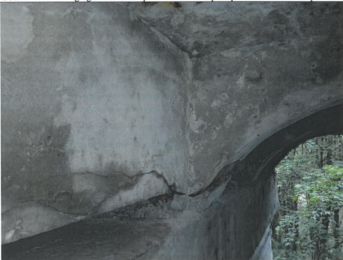
Foto 28 – Beton distrus in zona de reazem a boltilor din beton armat.
