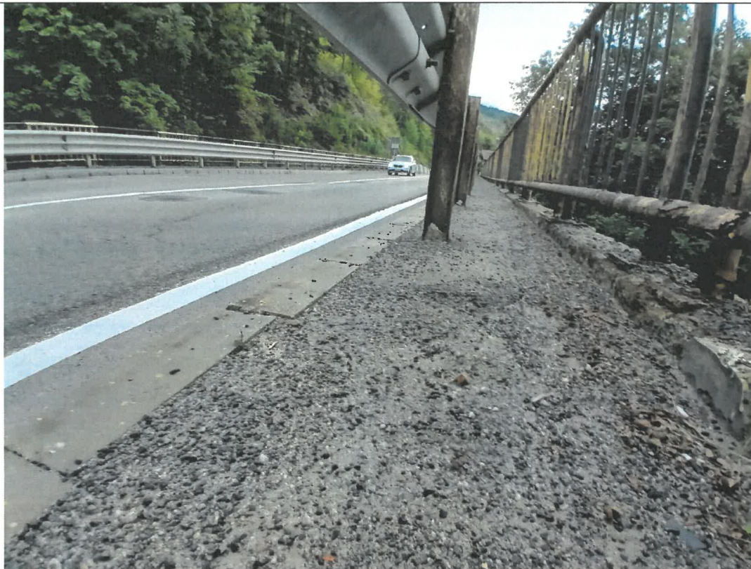
Foto 11 – Ciupituri, valuriri, si material granular depozitat pe calea trotuarului.
