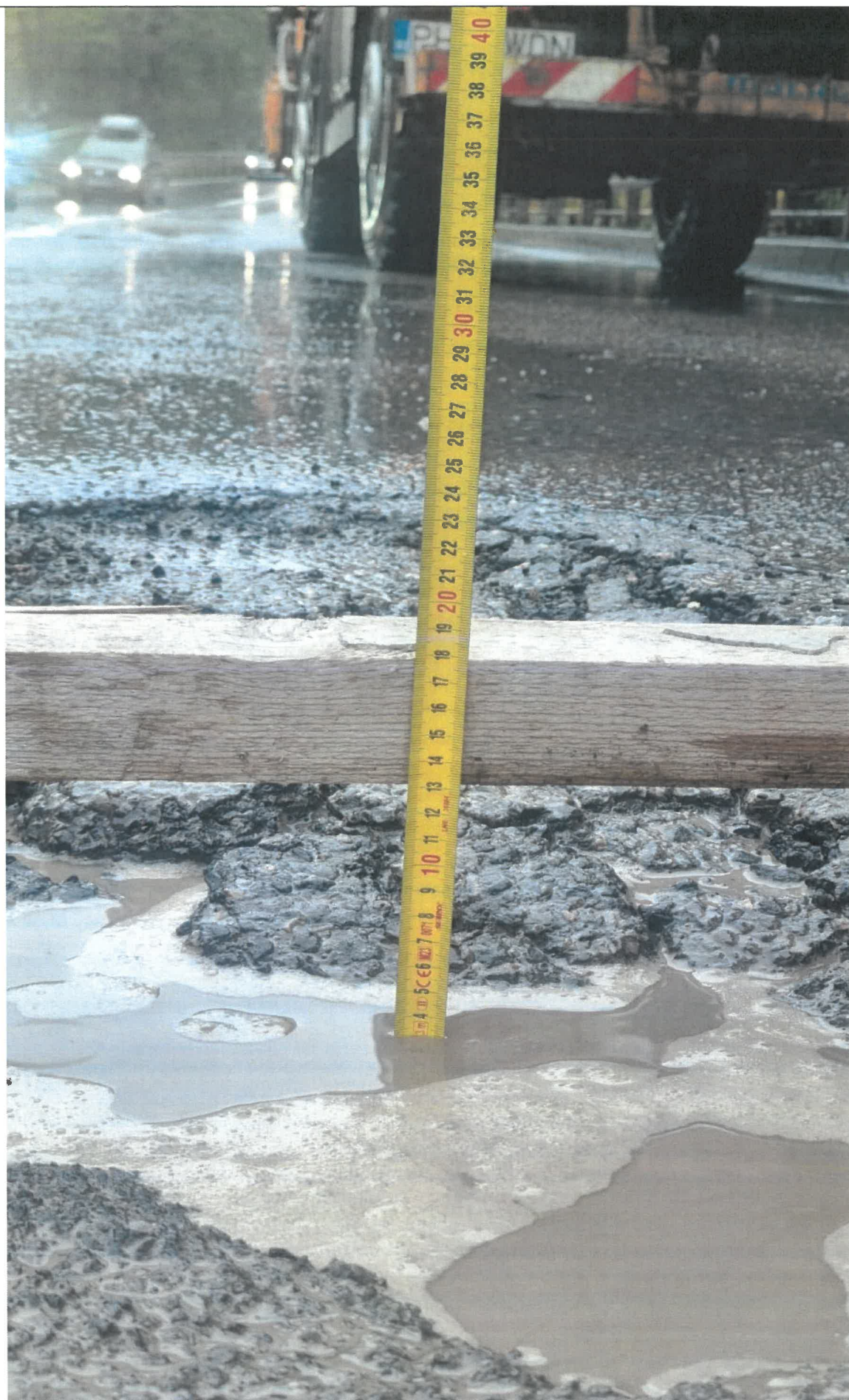
Foto 15 Distrugerea totala a lucrarilor de reparatii locale cu mixtura asfaltica a dus la aparitia de cratere cu adancimea de 13 cm - 15 cm.
