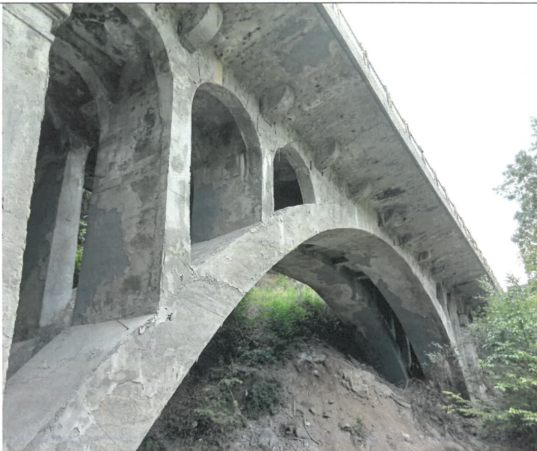
Foto 43 – Armături puternic corodate fara strat de acoperire si cu sectiunea redusa atat la intradosul consolelor trotuarului cat si la intradosul arcului dar si a boltilor de descarcare.
