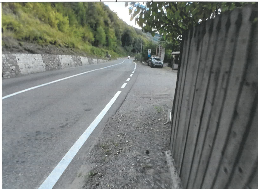
Foto 8 – Denivelari accentuate ale partii carosabile de pe rampa de acces.
