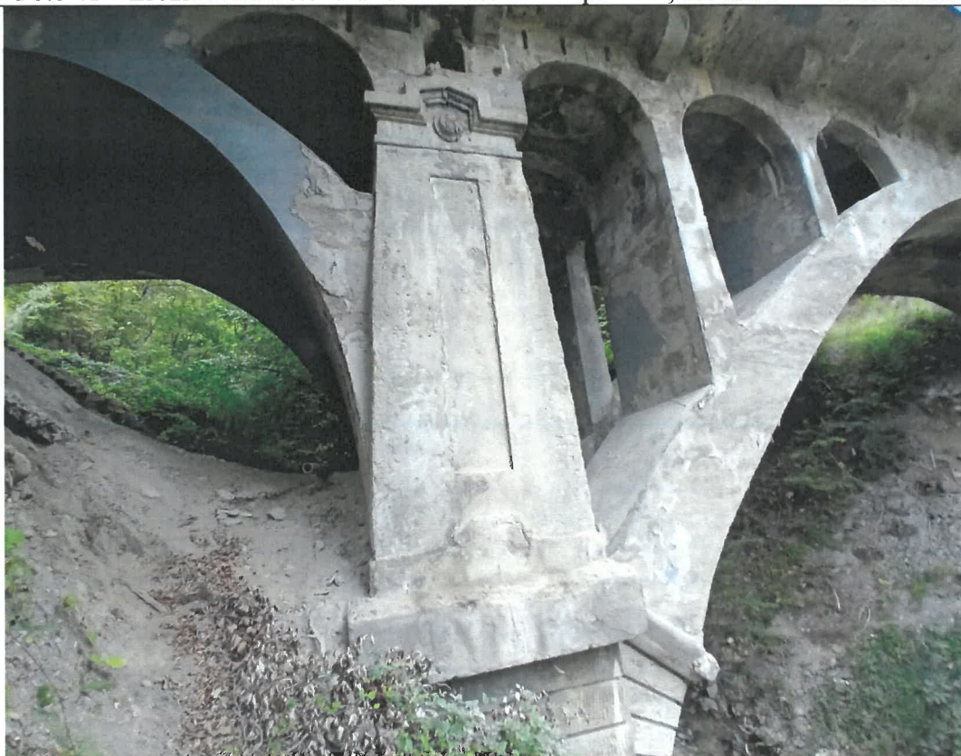
Foto 42 – Protectia anticoroziva distrusa, eroziuni ale betonului, carbonatari, eflorescente dar si multiple fisuri si crapaturi.
