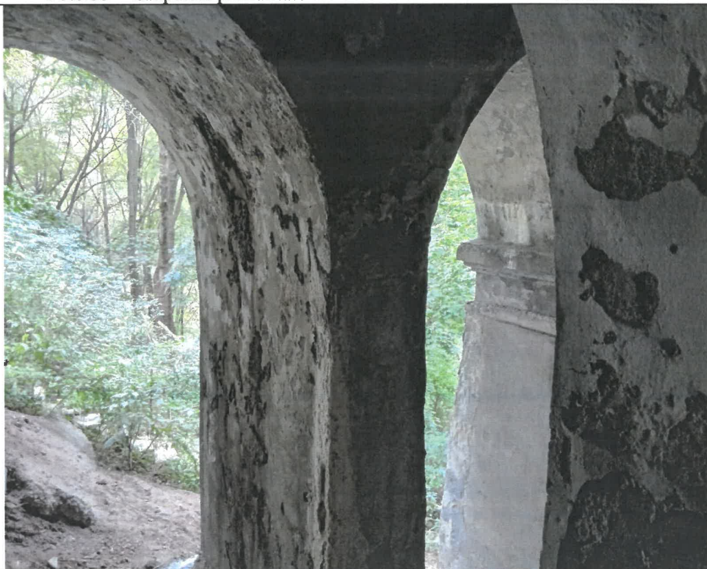
Foto 34 – Sectiune initiala redusa a betonului din boltile podului.
