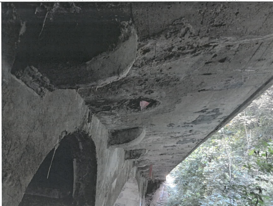
Foto 48 - Tuburile prelungitoare sunt parțial distruse, iar gurile de scurgere sunt colmatate.
