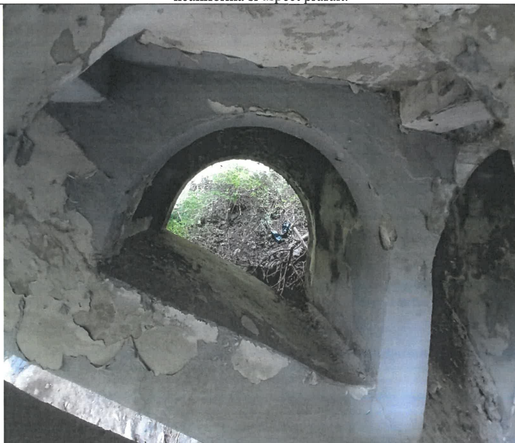
Foto 38– Boltile de descarcare de pe arcul central prezinta un beton degradat, cu multiple crapaturi si protectia anticoroziva distrusa.
