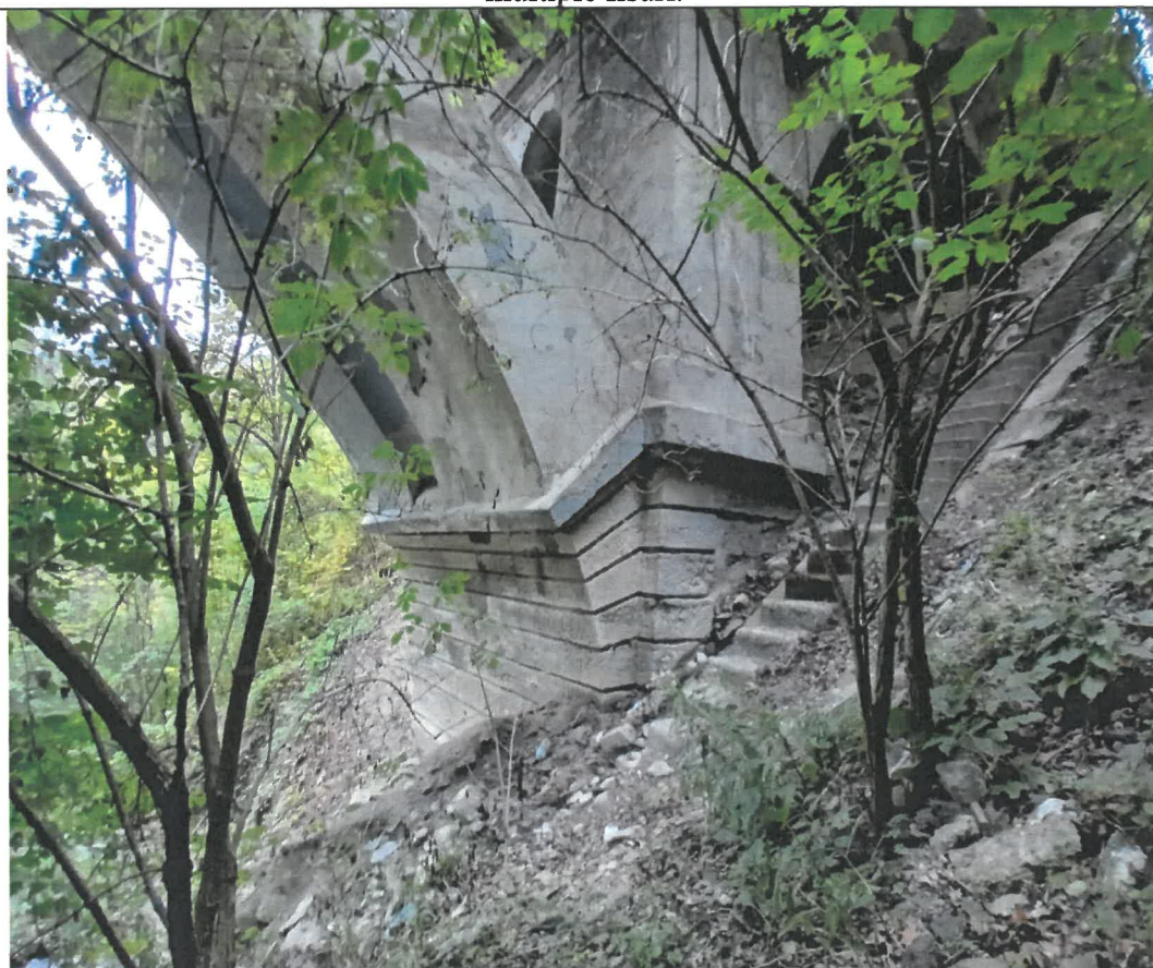
Foto 40 – Eroziuni masive ale taluzului versantului ca urmare a scurgerii libere ale apelor pluviale provenite de la santul de beton de pe rampa de acces.
