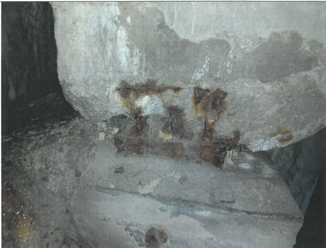
Foto 29 – Aparatele de reazem sunt puternic corodate fiind inglobate in praf si murdarie.
