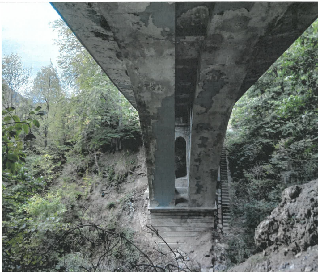
Foto 39– Protecție anticorozivă distrusă, infiltrații puternice, carbonatari, beton cu aspect friabil și multiple fisuri.
