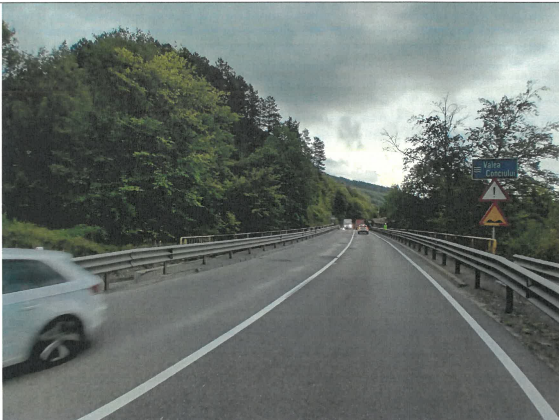
Foto 3 – Acces pe pod de pe rampa de acces Brasov-Posada – Valuriri ale partii carosabile de pe rampele de acces.
