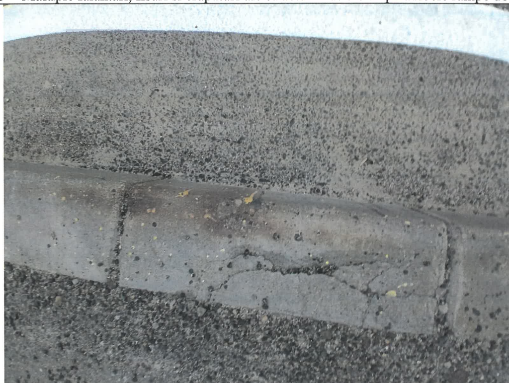
Foto 10: Bordurile prezinta local fisuri, crapaturi, beton desprins si local acestea sunt dislocate.
