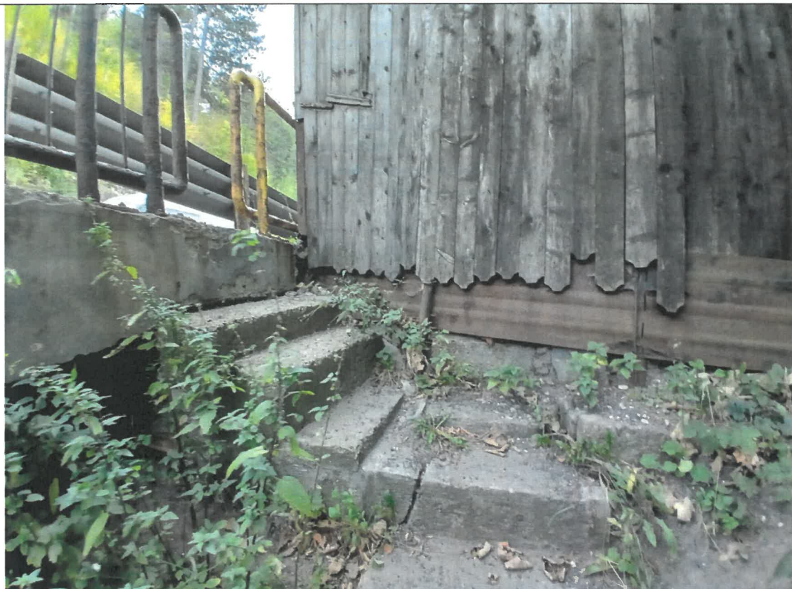
Foto 19 – Scarile de acces din beton prezinta fisuri, crapaturi, vegetatie crescuta pe acestea si nu sunt dotate cu mana curenta.
