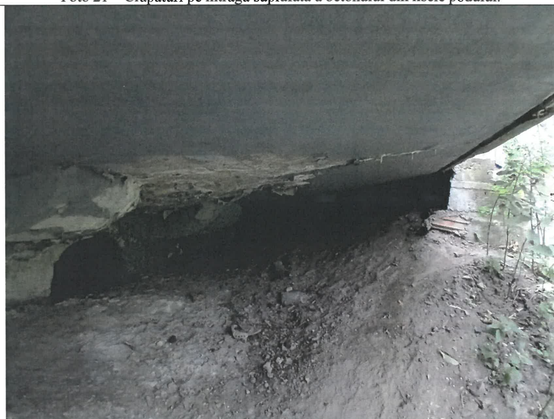
Foto 22 – Umpluturi de pamant masive depozitate pe zonale de capat ale podului.
