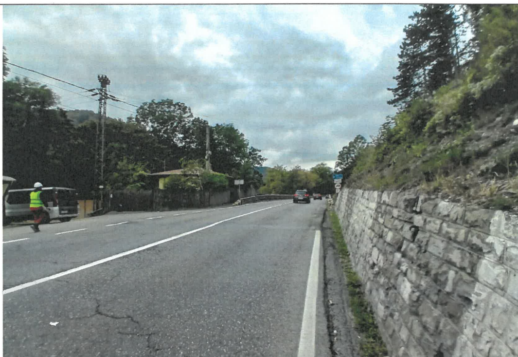
Foto 1 – Rampa de acces pe pod Posada-Bucuresti; Asfaltul prezinta fisuri locale, faiantari si fagase.
