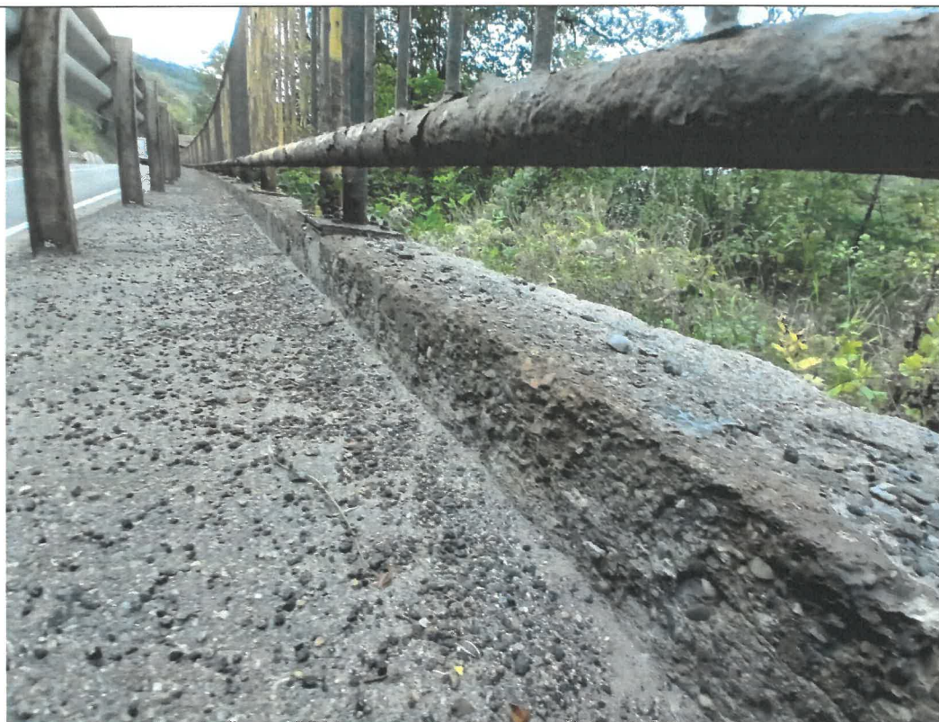
Foto 7 – Lisa podului prezintă degradări avansate ale betonului, manifestate prin eroziuni ale stratului superficial, agregate neconforme, neînglobate în pasta de ciment, precum și prin prezența unor fisuri și crăpături multiple.
