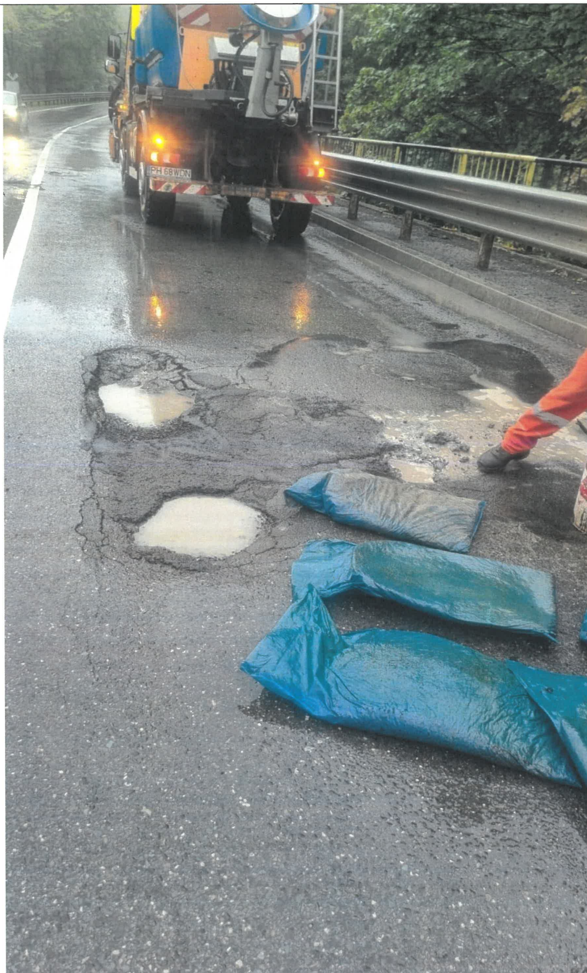
Foto 16 – Lucrări de reparații locale cu mixtură asfaltică aplicată la rece.
