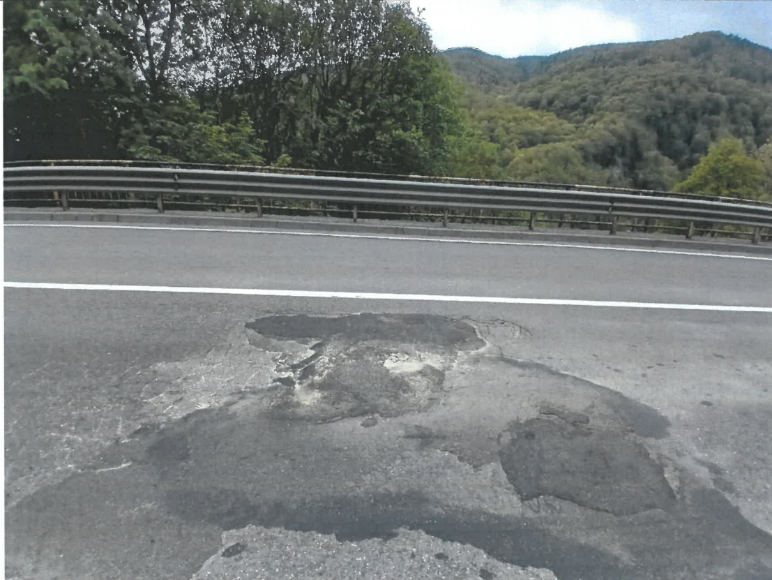
Foto 14 – Lucrari de reparatii provizorii realizate neconform, ce produc disconfort participantilor la trafic favorizand aparitia de vibratii pe toata suprapstructura podului.
