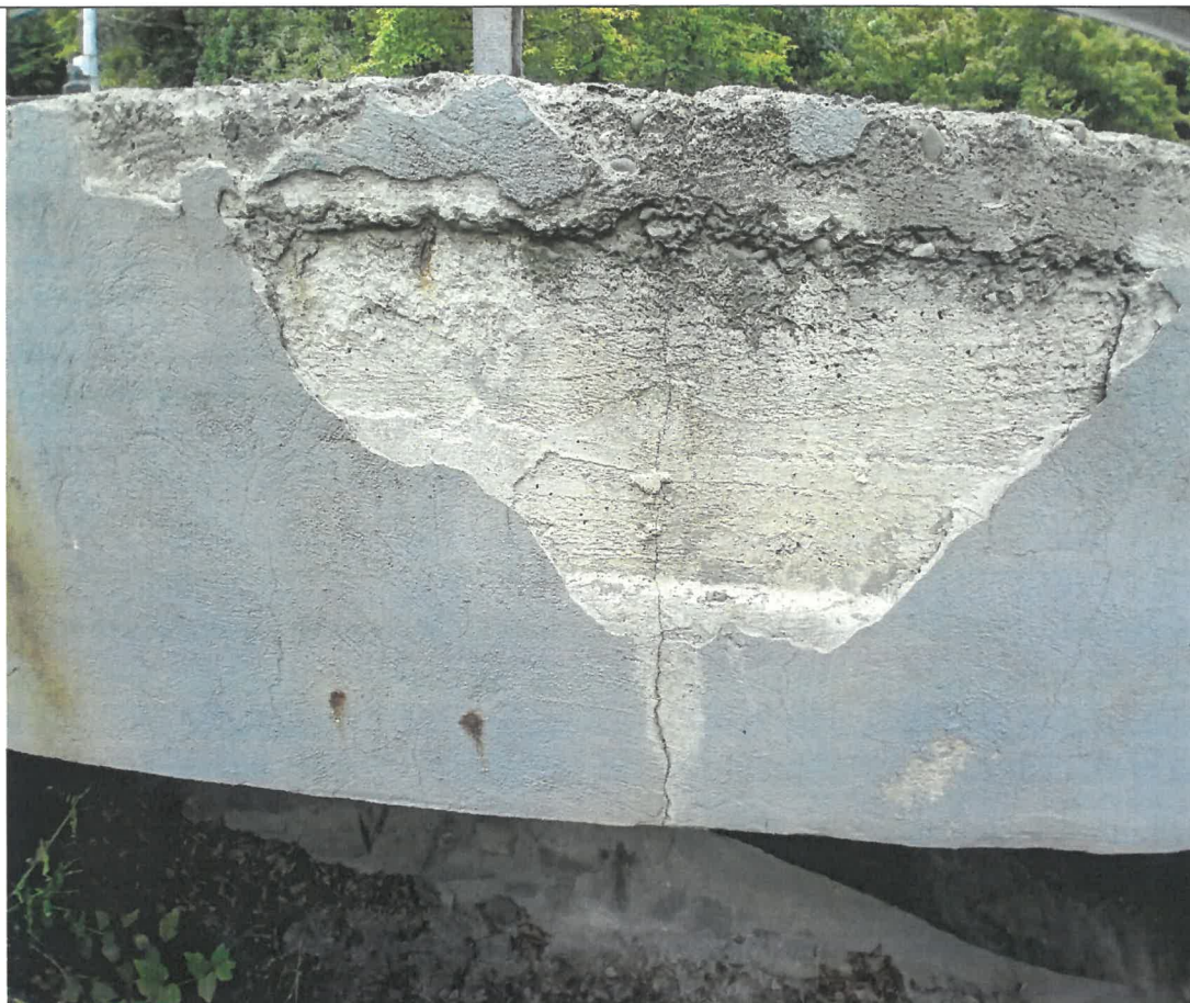
Foto 21 – Crapaturi pe intraga suprafata a betonului din lisele podului.
