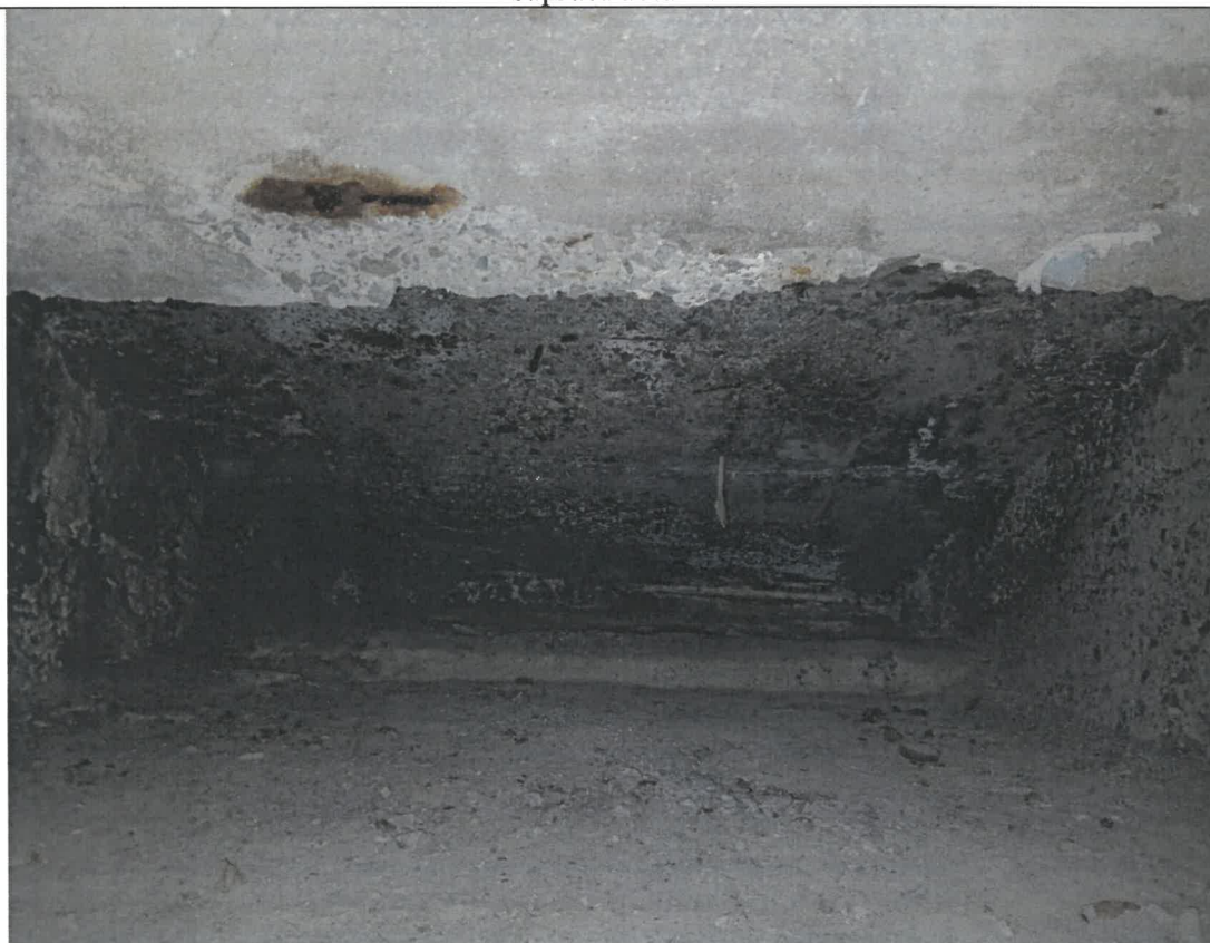
Foto 26 – Armături corodate, fara strat de acoperire, beton segregat, fisuri si crapaturi ale betonului din dala podului.
