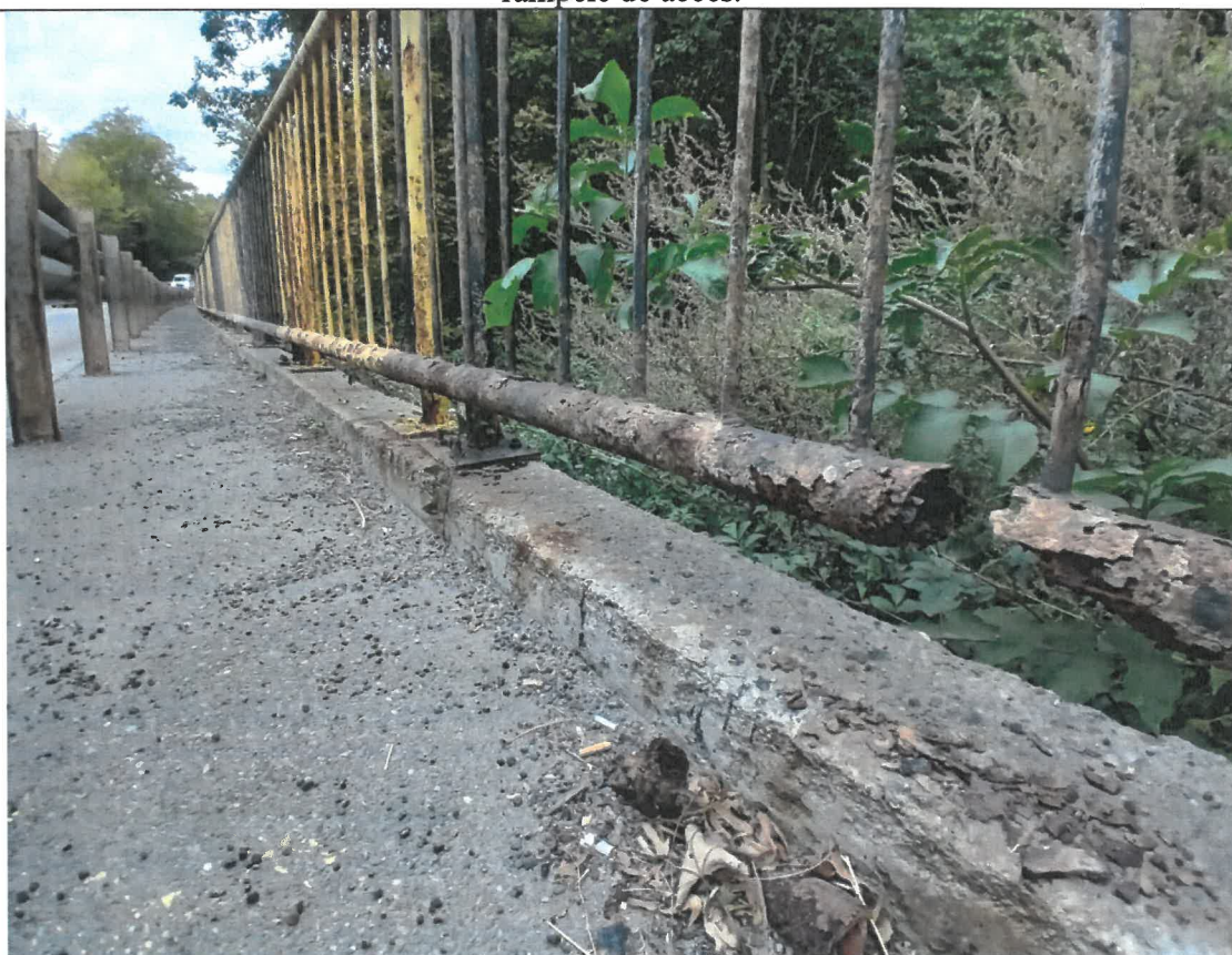
Foto 4 – Parapet pietonal puternic corodat cu elemente rupte.
