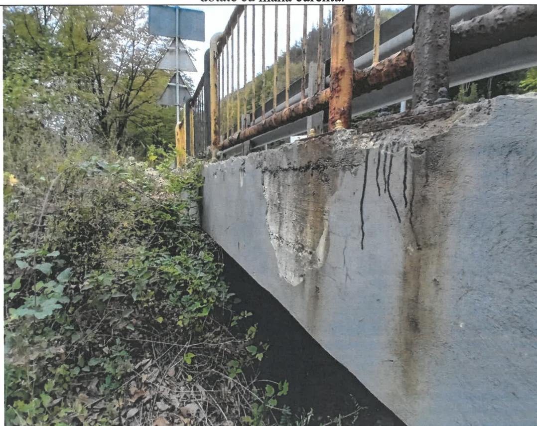
Foto 20 – Tencuiala desprinsa, sectiune initiala redusa dar si fisuri si crapaturi ale betonului din lise.
