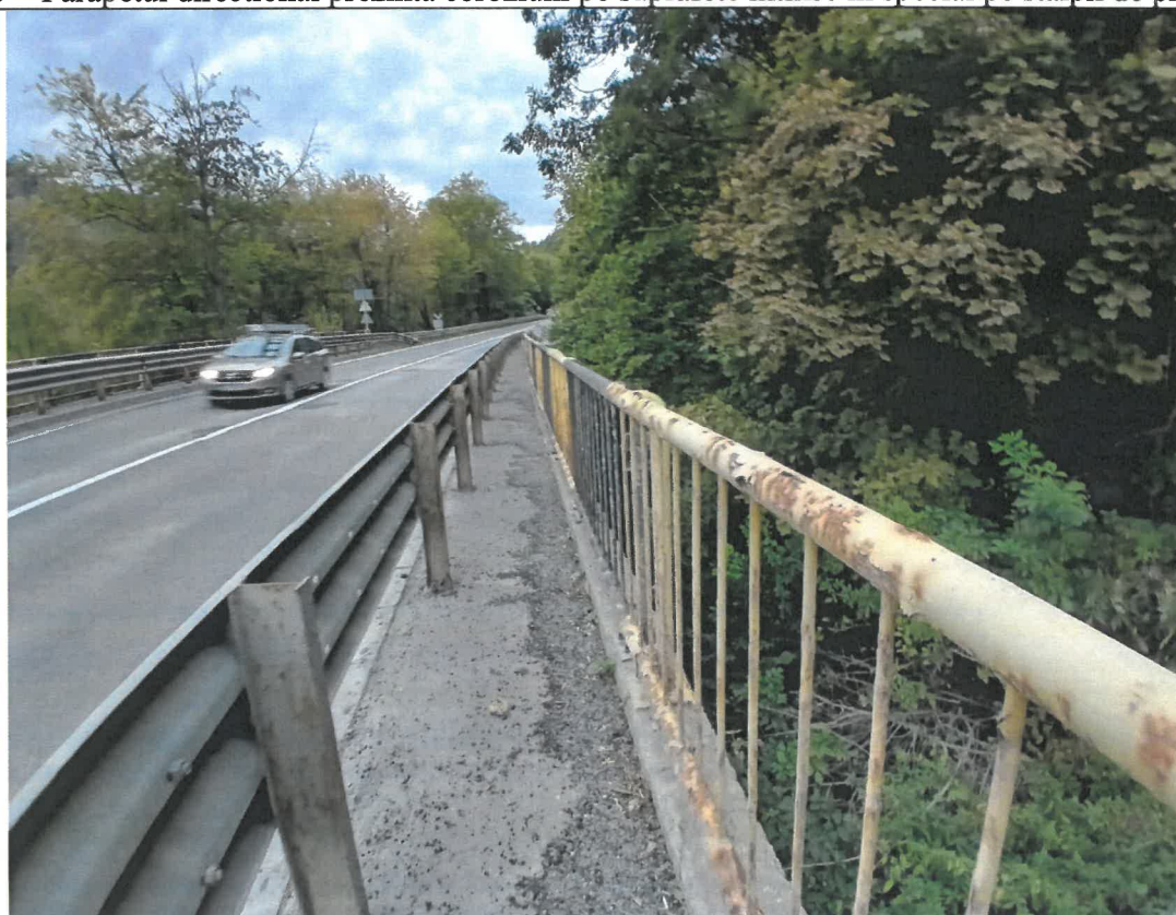
Foto 6 – Calea pe trotuare prezinta material granular si vegetatie crescuta pe suprafata acestuia.
