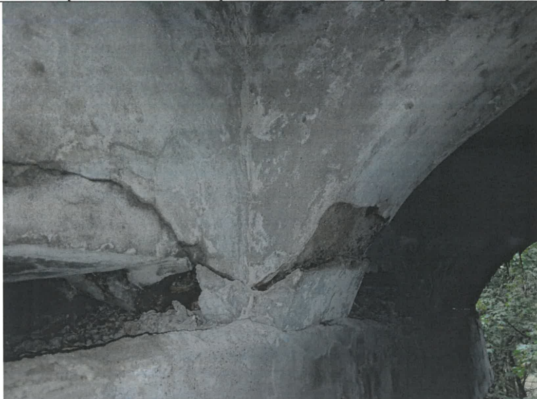
Foto 30 – Sectionarea betonului si desprinderi pe suprafete intinse ale acestuia in zona de descarcare a boltilor pe zona pilelor.
