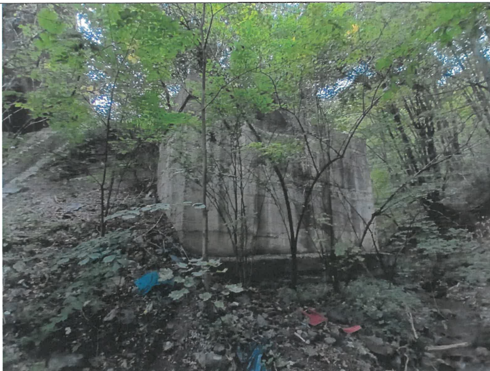
Foto 49 - Veche culee din beton armat. Probabil s-a folosit la varianta provizorie cand s-au realizat lucrari la pod.
