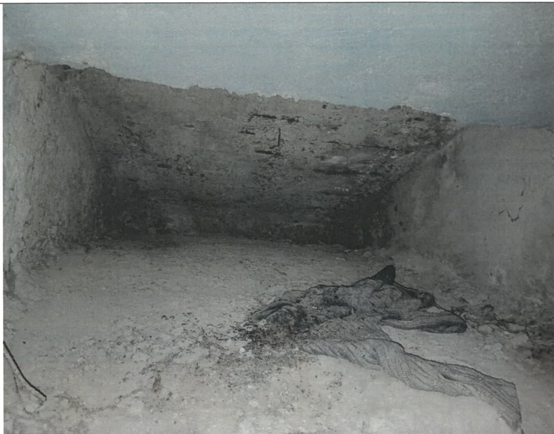
Foto 27 – Beton segregat si armaturi puternic corodate pe suprafata antretoazelor podului.
