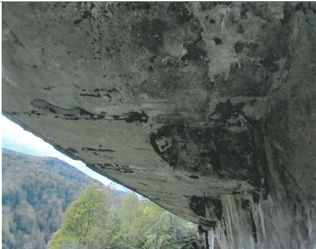
Foto 45 - Beton cu aspect friabil, exfolieri, beton segregat, protectia anticoroziva distrusa dar si stalactite formate la intradosul consolelor trotuarului.
