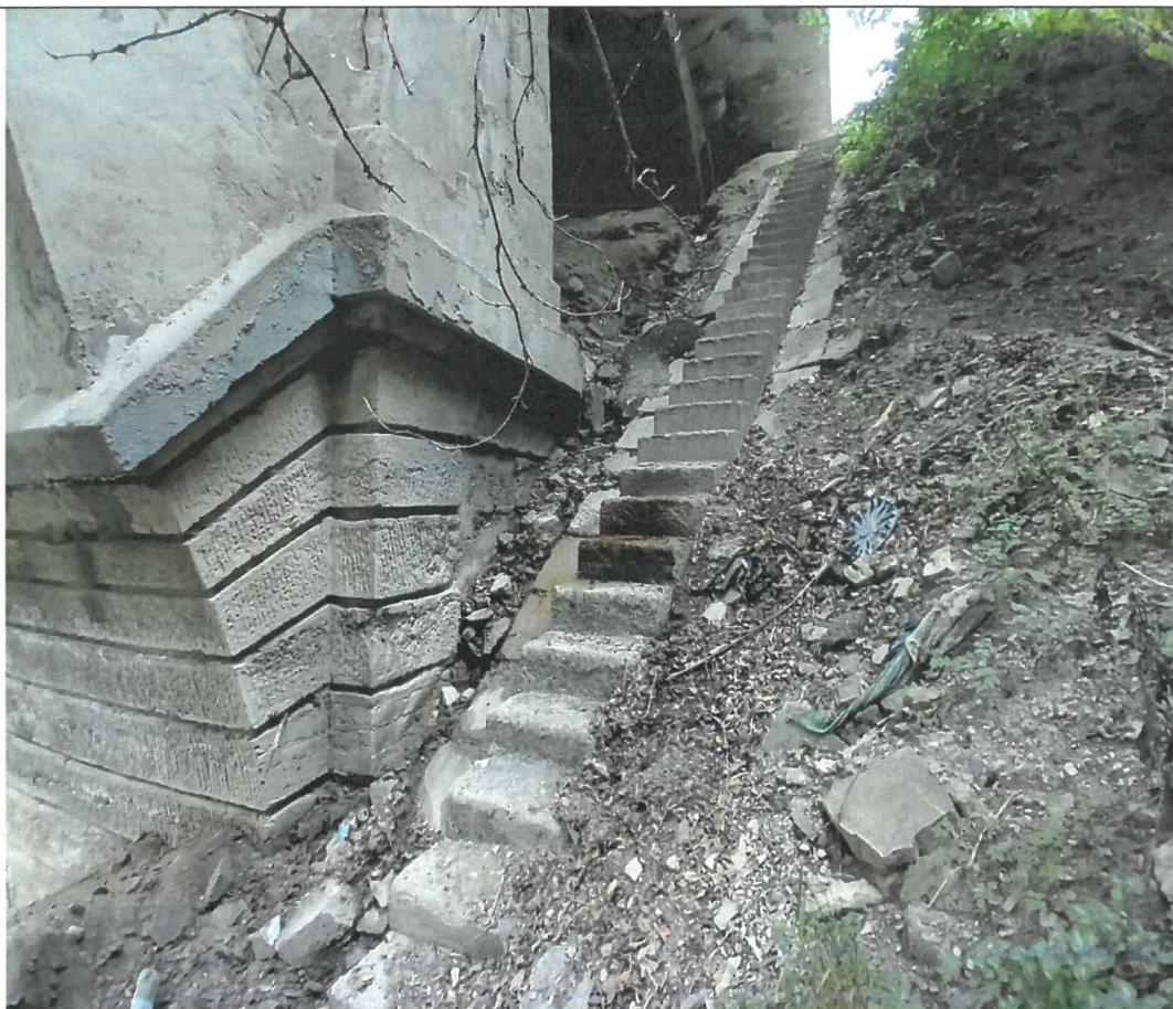
Foto 41 – Eroziuni ale betonului din infrastructura podului, dar si a scarilor de acces.
