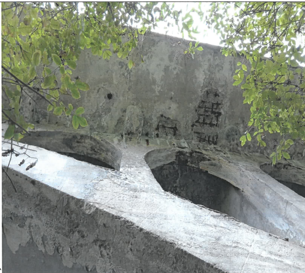
Foto 44 - Sectiune initiala redusa a betonului de la intradosul boltilor din beton dar si la intradosul consolelor.
