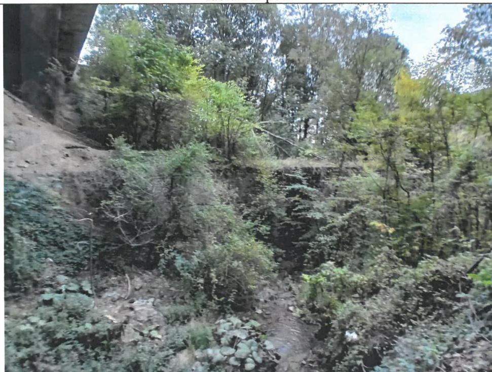
Foto 50 - Zid de sprijin din zidarie de piatra puternic degradat, cu moloane desprinse si cu vegetatie abundenta crescuta pe suprafata acestuia.
