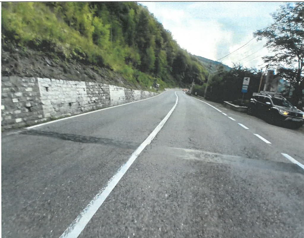
Foto 9 – Multiple faiantari, fisuri si crapaturi ale structurii rutiere de pe ambele rampe de acces.
