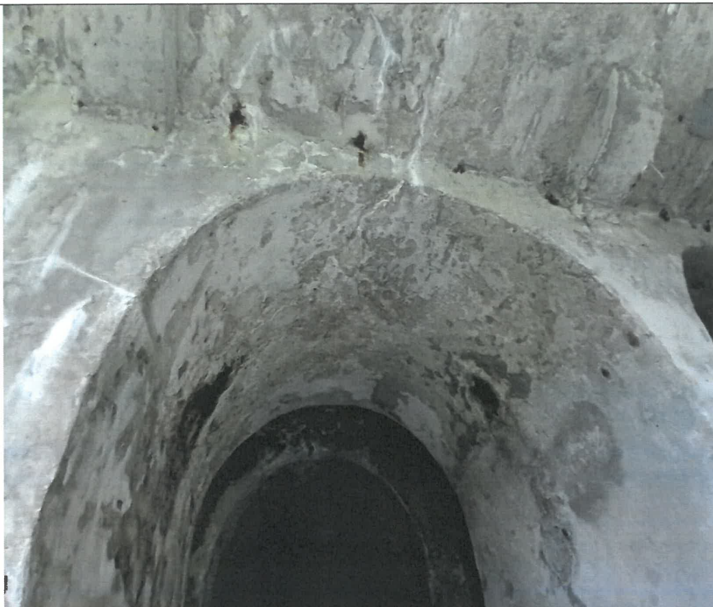
Foto 35 – La intradosul boltilor din beton sunt prezente multiple infiltratii, carbonatari, eflorescente, fisuri si crapaturi pronuntate ale betonului.
