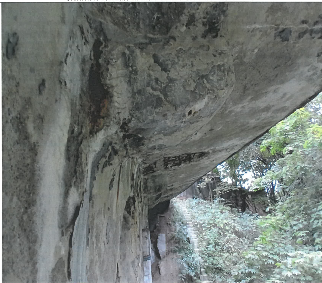
Foto 46 - Betonul, din antretoaze are sectiunea initiala redusa datorita cumularii defectelor asupra elementelor.
