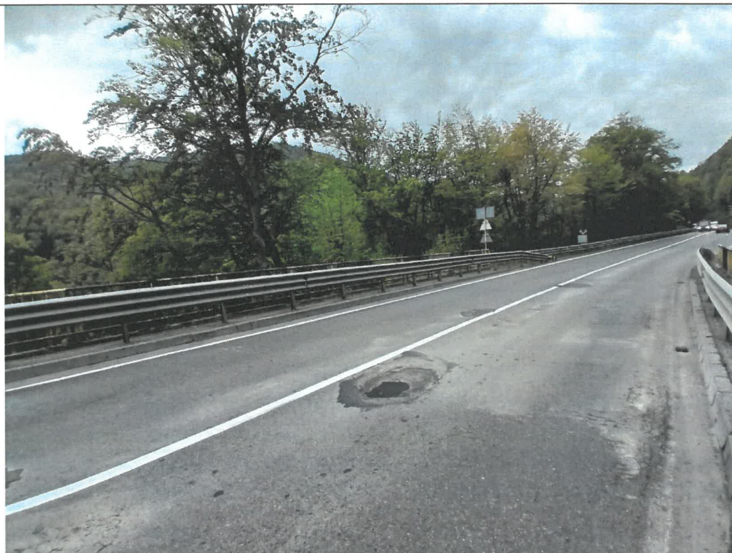
Foto 17 – Multiple zone cu plombe si fagase pronuntate formate la marginea partii carosabile.
