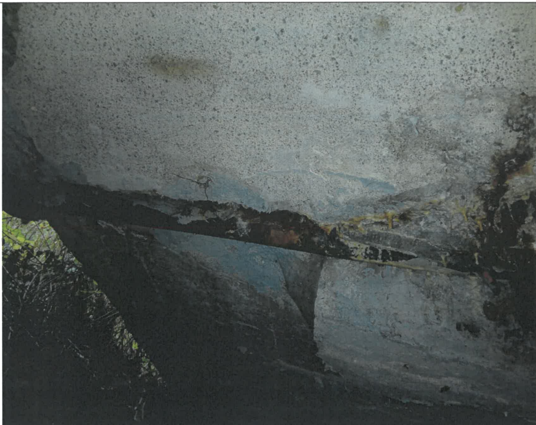
Foto 47 - Rosturile de dilatație sunt distruse în totalitate și blocate.
