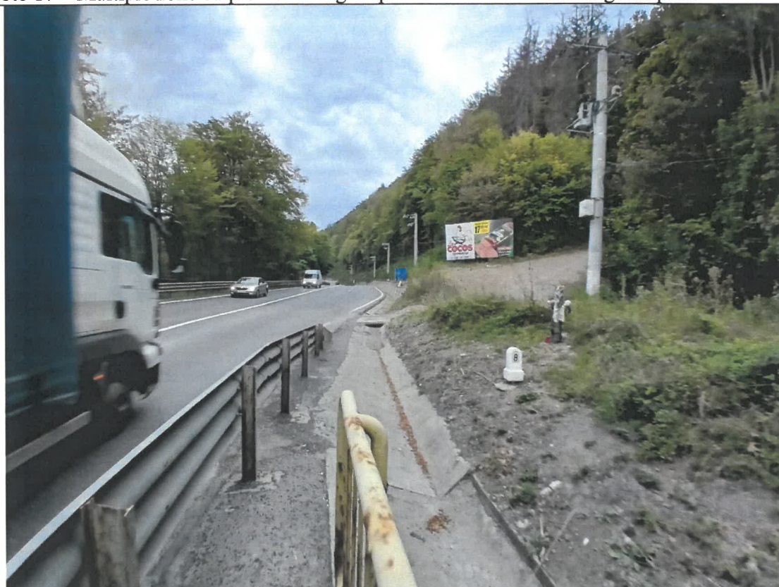
Foto 18 – Rampele de acces prezinta vegetatie arboricola abundenta. Local, santul din beton este colmatat cu material granular.
