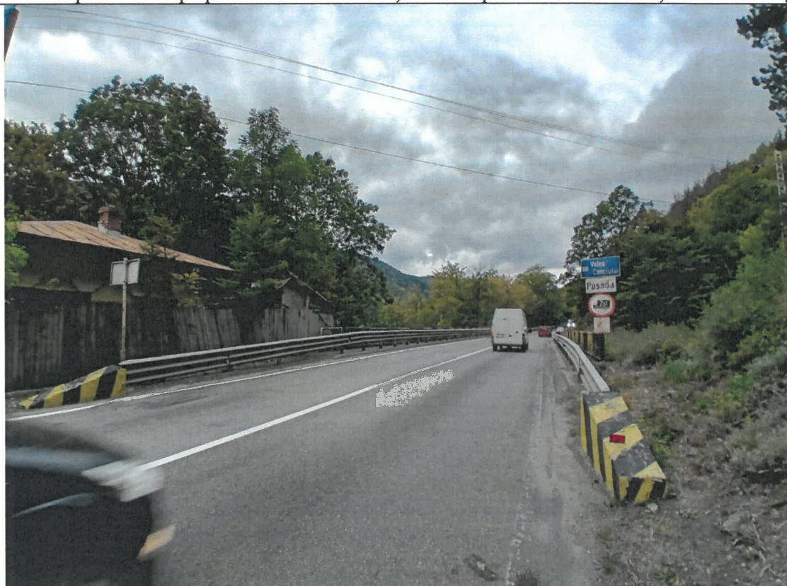
Foto 2 – Rampa de acces pe pod Posada-Brasov. Acostamente inierbate; Neasigurarea scurgerii apelor pluviale de pe partea carosabila. Acces dificil pe trotuarele podului.
