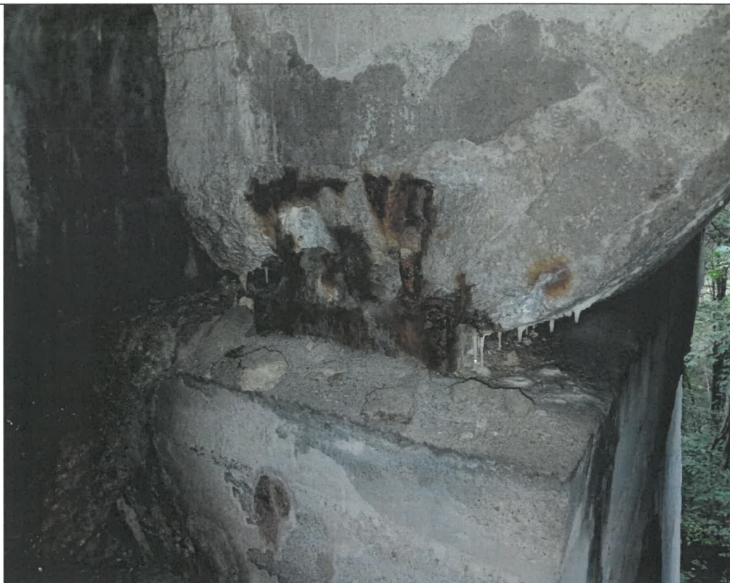
Foto 31 – Infiltrații puternice, aparat de reazem puternic corodat cu secțiunea redusă.
