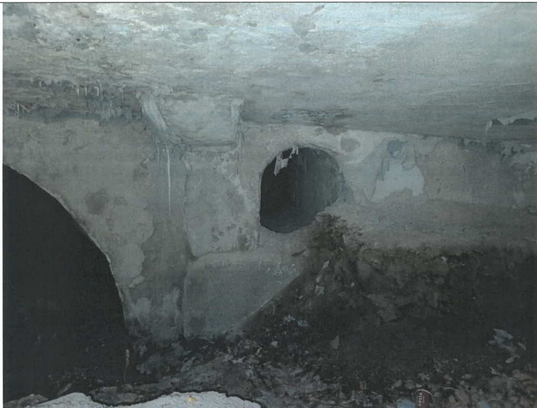
Foto 25 – Stalactite multiple, eflorescente si carbonatari pe suprafete intinse la intradosul suprastructurii.
