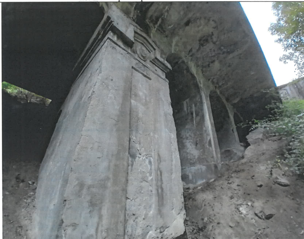
Foto 36 – Betonul din infrastructura prezinta multiple fisuri, crapaturi, carbonatari, eflorescente, sectiunea initiala redusa dar si beton cu aspect friabil.
