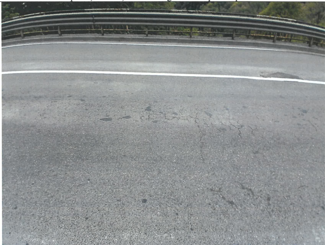
Foto 12 – Valuriri, faiantari in panza de paianejn si fagase pe intrega suprafata a caii de pe pod.
