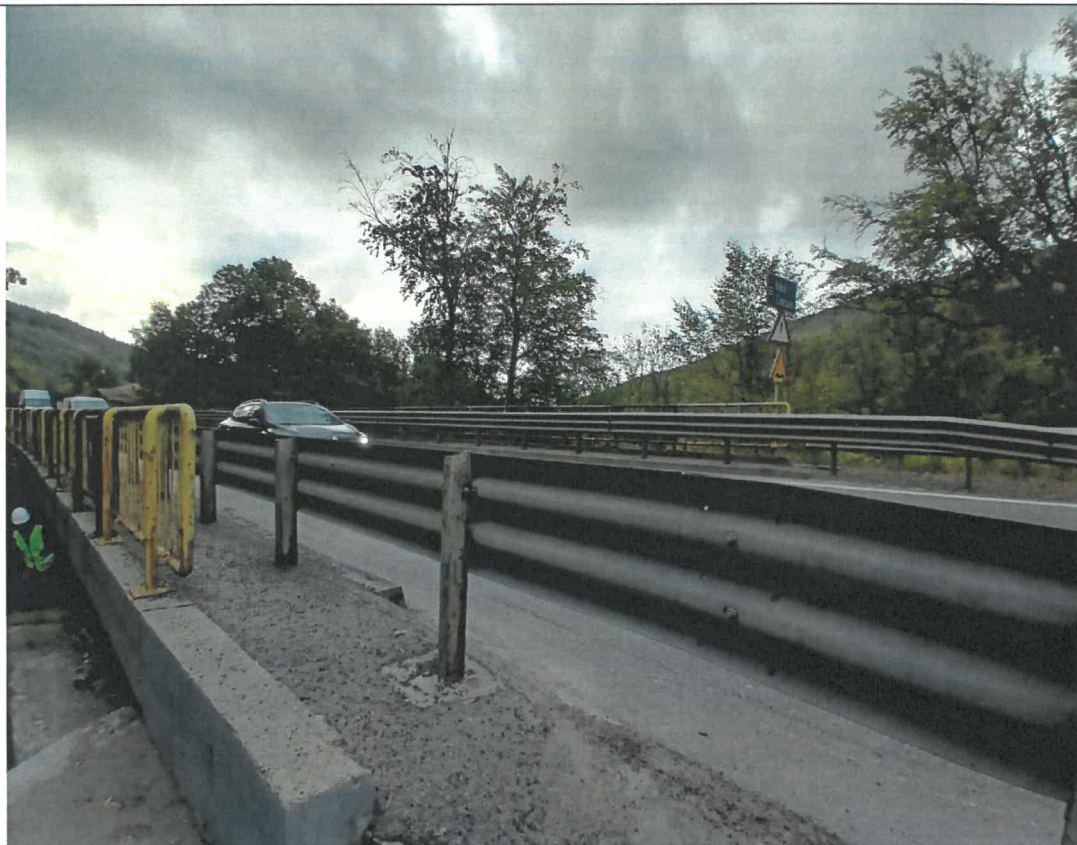
Foto 5 – Parapetul directional prezinta coroziuni pe suprafete intinse in special pe stalpii de prindere.
