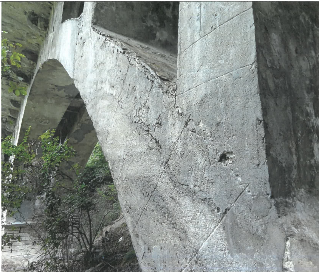
Foto 37 – Arcul de pe deschiderea centrala a podului prezinta segregari ale betonului, culoare neuniforma si aspect prafuit.
