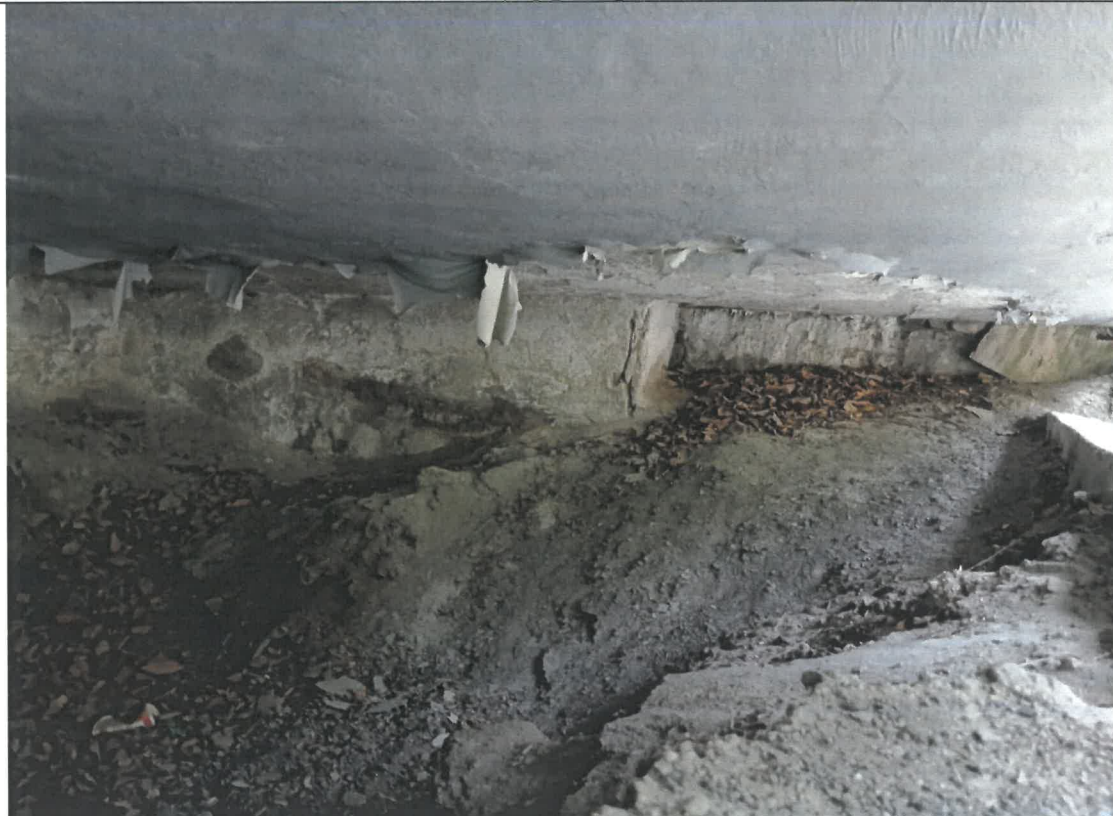
Foto 24 – Zidul de gardă prezintă multiple fisuri, crapături, armături puternic corodate și fără strat de acoperire.
