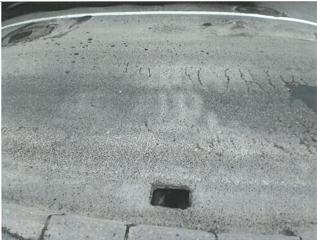
Foto 13 – Gurile de scurgere sunt partial colmatate, nefunctionale si cu tuburi prelungitoare distruse.
