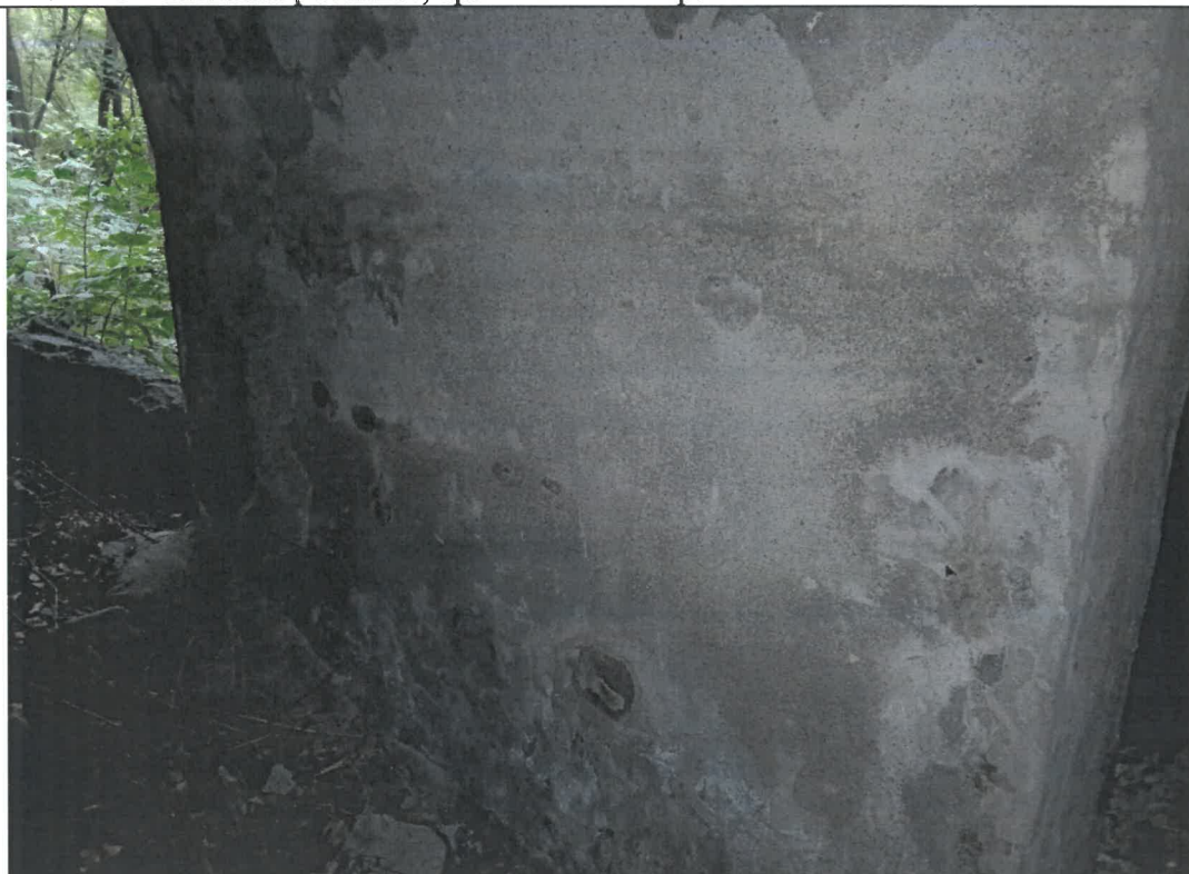
Foto 32: Carbonatări, eflorescențe și infiltrații, culoare neuniformă, aspect prafuit al tecuielii și lipsa protecției anticorozive.
